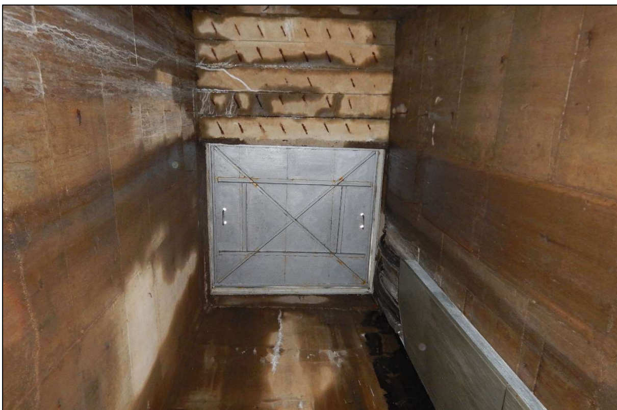
Obr. 4: Stávající zakrytí manipulačního otvoru a pref. stropnice šachty, 5/2020
