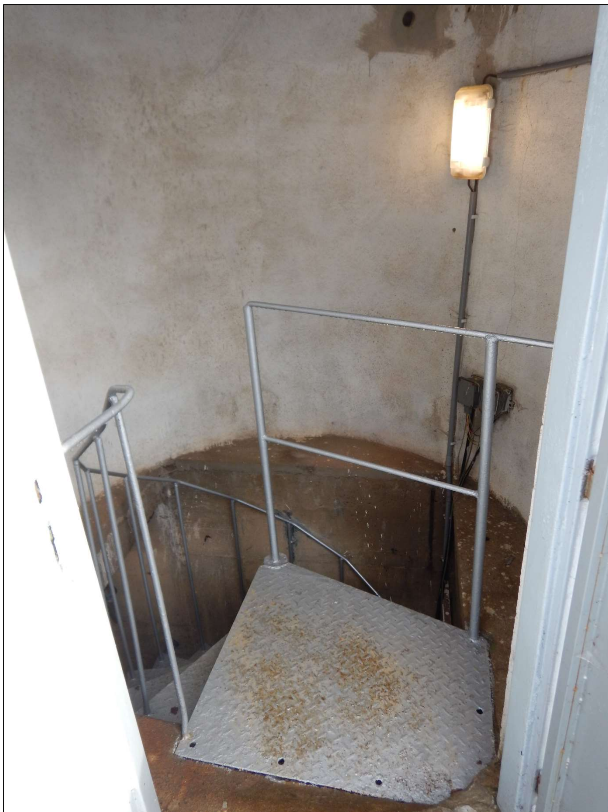
Obr. 10: Stávající vřetenové schodiště a nástupní podesta v 1NP
