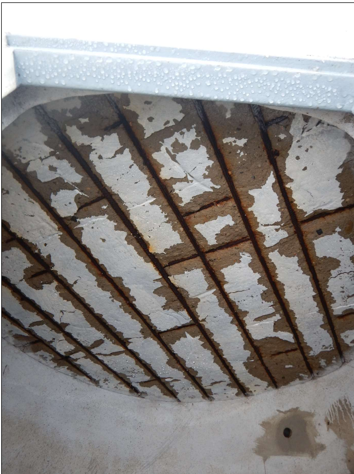
Obr. 9: Celková destrukce výztuže stropnice nadzemní části objektu, hloubk. koroze nad 50% profilu
